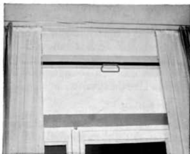
Rollfix-Bildwand mit Selbstrollvorrichtung fest montiert unter einer Vorhangschiene
